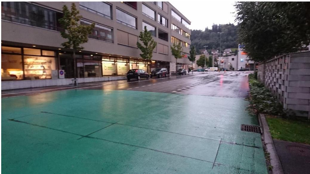
**Abbildung 3: Busanmeldeschleifen für die Fahrstreifen 4+5 (Foto vom 24.09.2018, M+P)**
