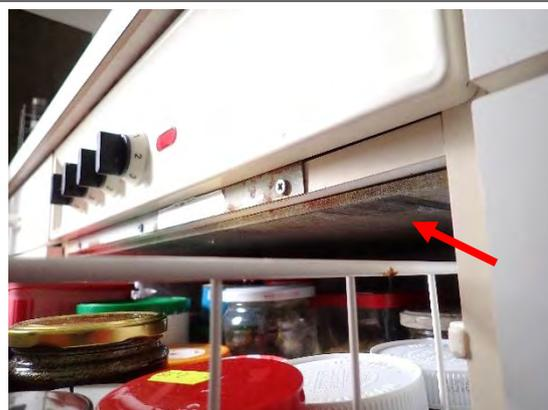
Brandschutzplatte aus Asbestzement
